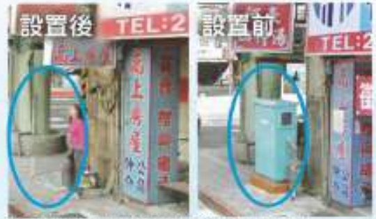
水壓監測創新管理，設備設置前後對照圖（臺北市）。
